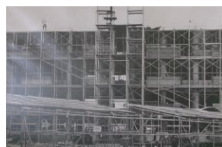
建築中の文蔵小学校
